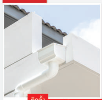
ติดตั้ง ชุดระบายน้ำระเบียงไวโนล เอสซีจี ช่วยควบคุมทิศทางการระบายน้ำ
