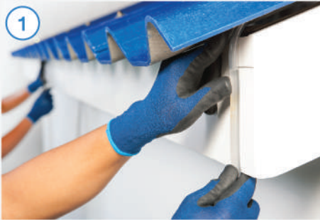
1. ทหารดับบนเชิงชายเพื่อทำการติดตั้งรางน้ำฝน โดยใช้สายยางวัดระดับน้ำ
