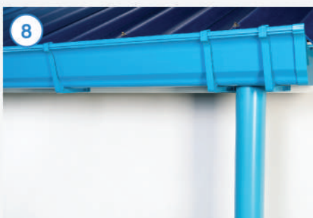
8. หลังจากติดตั้งเสร็จ ควรทดสอบการระบายน้ำ พร้อมทั้งเช็ดทำความสะอาดด้วยน้ำสบู่หรือน้ำยาล้างจาน Tips: กรณีต้องการติดตั้งโปรดก่อนฝนคอนกรีต เพื่อยึดท่อระบายน้ำฝนเข้ากับผนังบ้าน แนะนำให้ฝังพุกพลาสติกก่อน โดยติดตั้งคลิปตัวแรกห่างจากข้อต่อ 10 ซม. และติดตั้งคลิปตัวต่อไปให้ระยะห่างกับไม่เกิน 1 ม.
