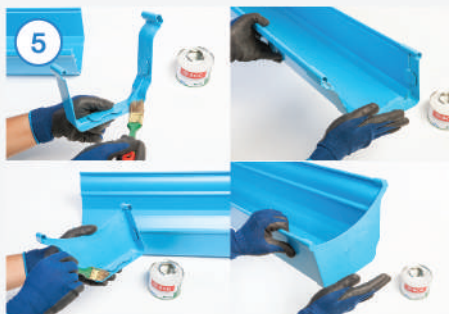
5. ประกอบชิ้นส่วนต่างๆ ของรางน้ำฝนเข้าด้วยกันด้วยน้ำยาประสานท่อพีวีซี
